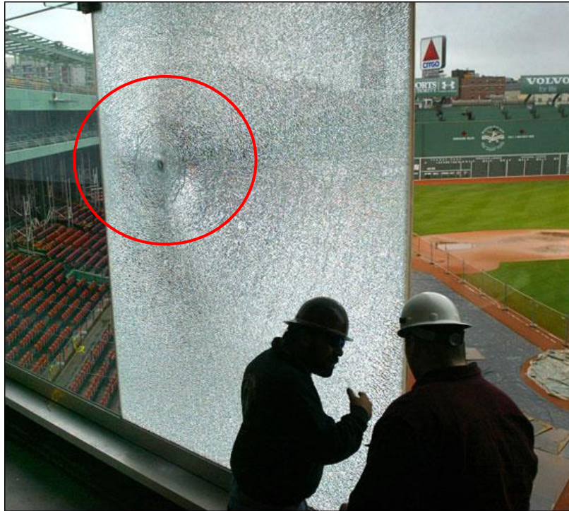
Fractura con origen al centro de la lámina. Busque daño o punto de impacto en la superficie.
