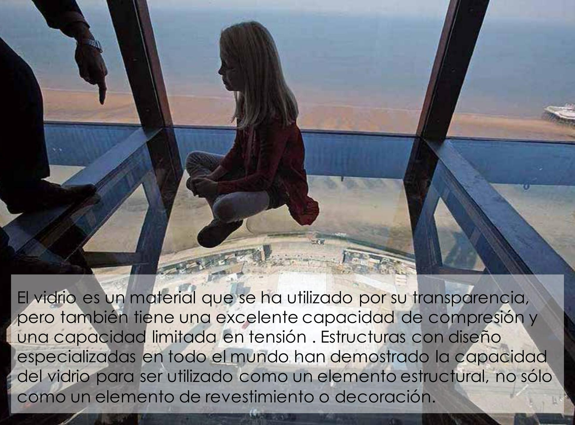
El vidrio es un material que se ha utilizado por su transparencia, pero también tiene una excelente capacidad de compresión y una capacidad limitada en tensión . Estructuras con diseño especializadas en todo el mundo han demostrado la capacidad del vidrio para ser utilizado como un elemento estructural, no sólo como un elemento de revestimiento o decoración.
