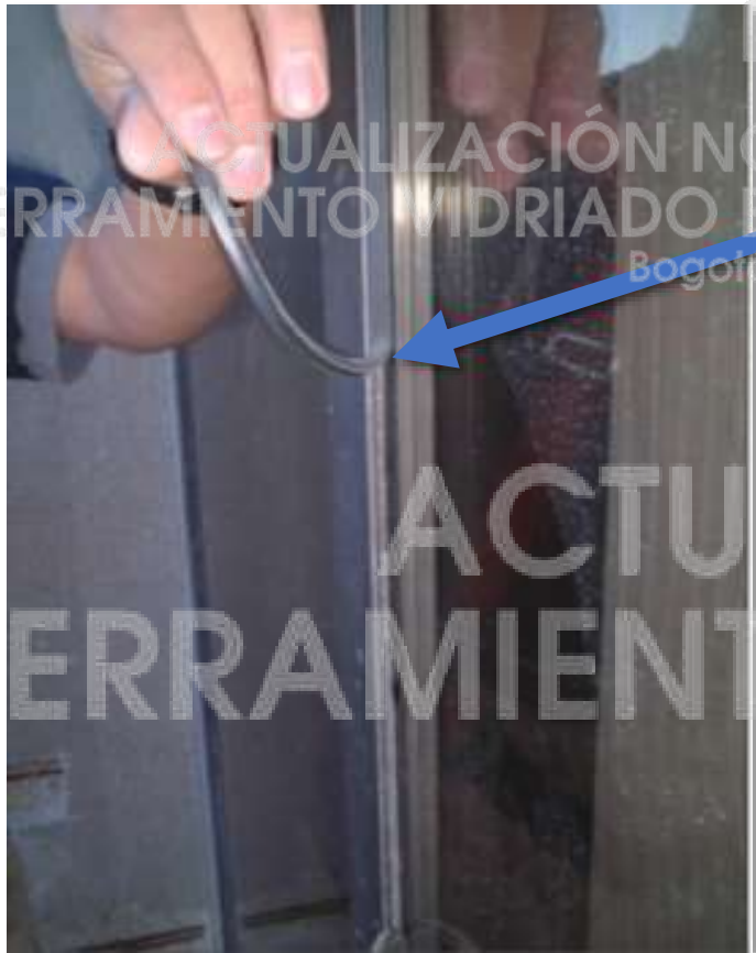
Sellado insuficiente
