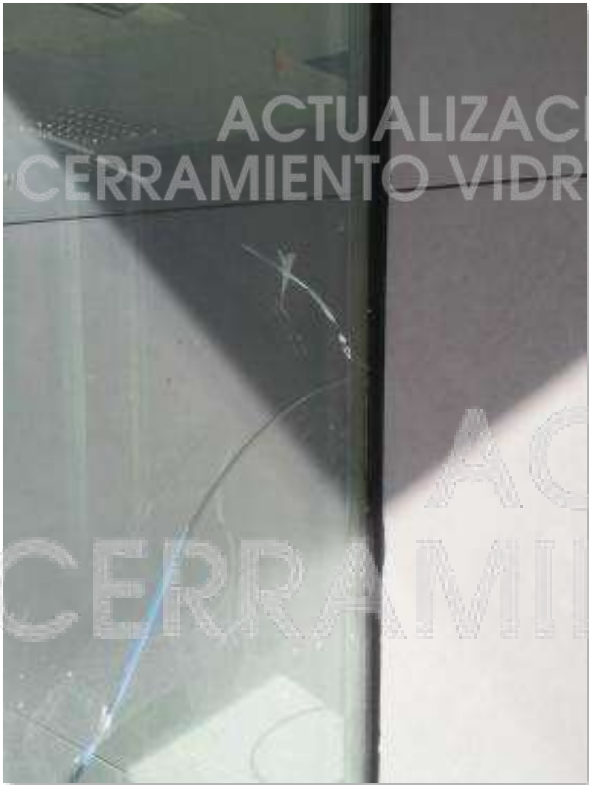
Patrón típico de la falla por estrés térmico en el vidriado
