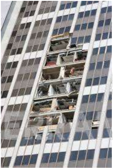
Falla: desvidriado de los paneles de la fachada
